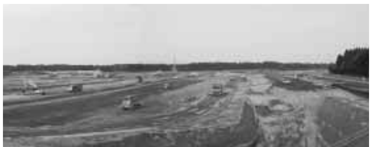
多くの建設機械が稼動する工事現場
