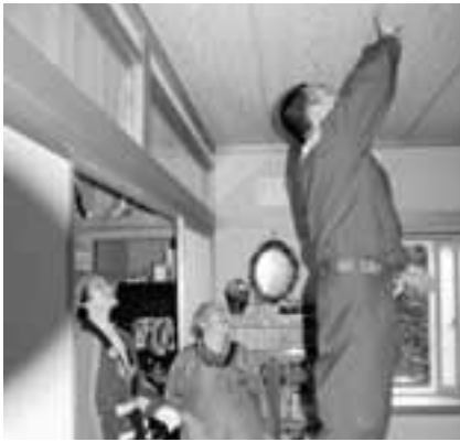
▲寝室に警報器を設置している様子
