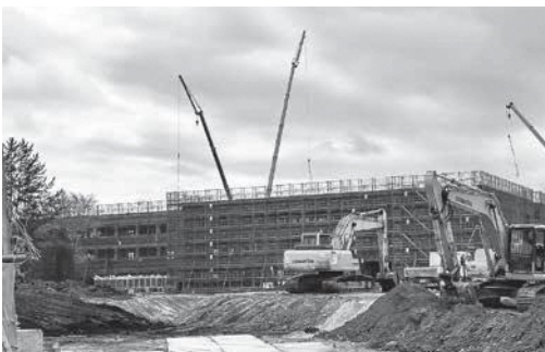
建設中の六戸学園 (令和6年4月22日撮影)
