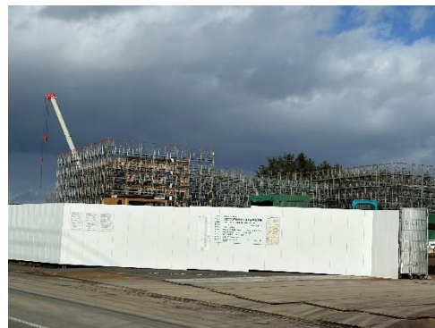
六戸学園校舎建設工事の様子
