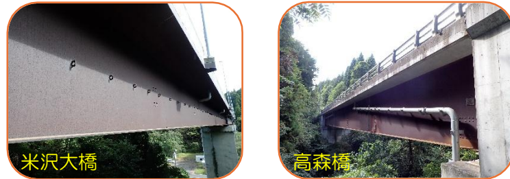
【図-1 対象橋梁の状況】
