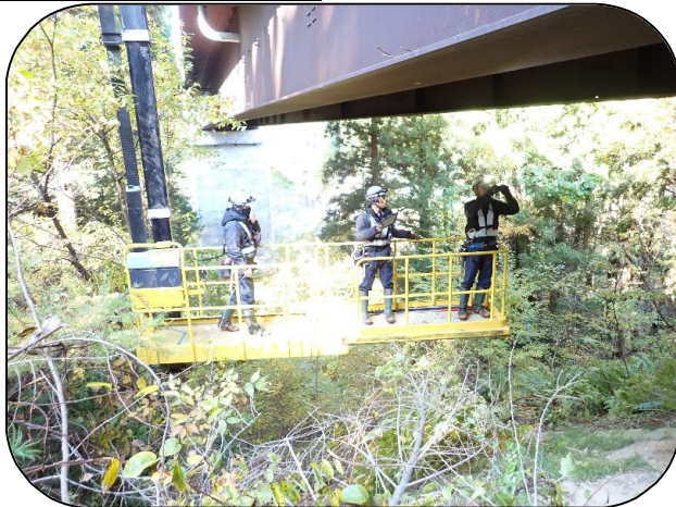
米沢大橋点検状況 【橋梁点検車による点検】
