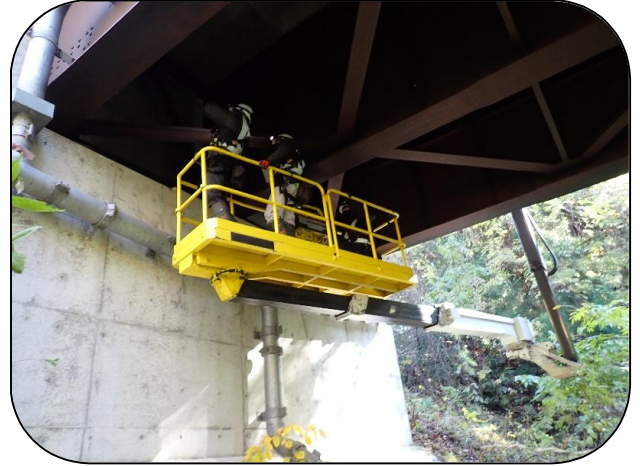
高森橋点検状況 【橋梁点検車による点検】
