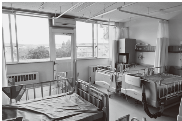
1年以上使用されていない2階南側病室
