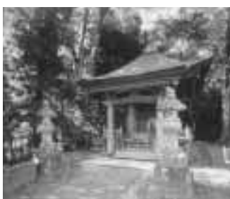
義経が最後をとげたとされている場所に建つ「義経堂」(平泉町・高館)
