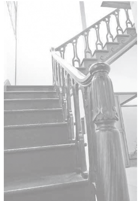
二代目清水喜助作の「黒柿の階段」。手すりは釘を一本も使っていない組み立て式の精密な造作
