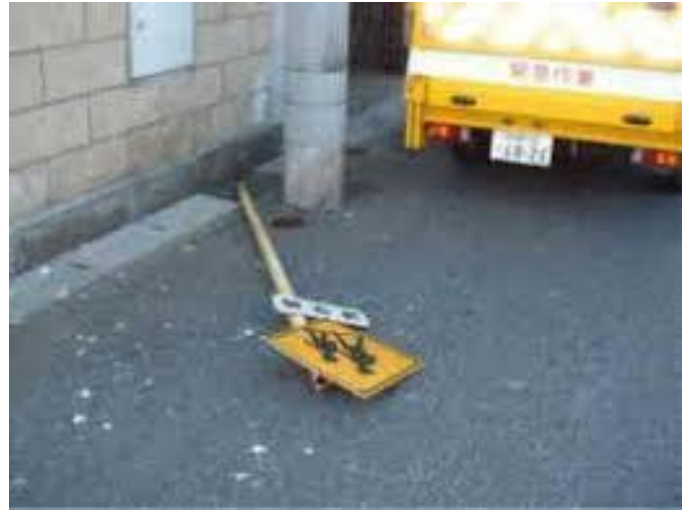
●警戒標識が倒れている。
