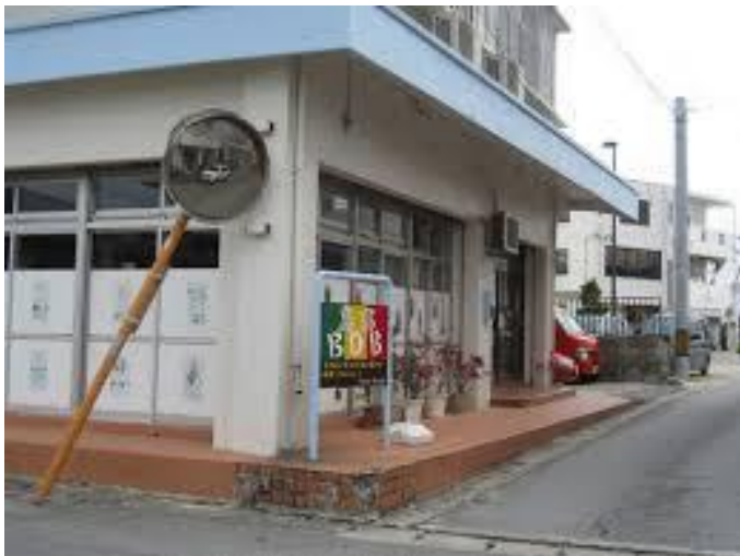
●カーブミラーが倒れている。
