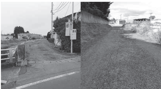
▶簡易舗装工事をした七百地区稲生川沿いの砂利道
