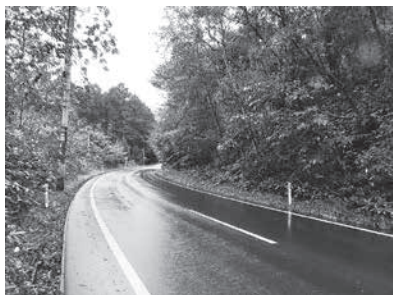
県道211号線権現沢付近
