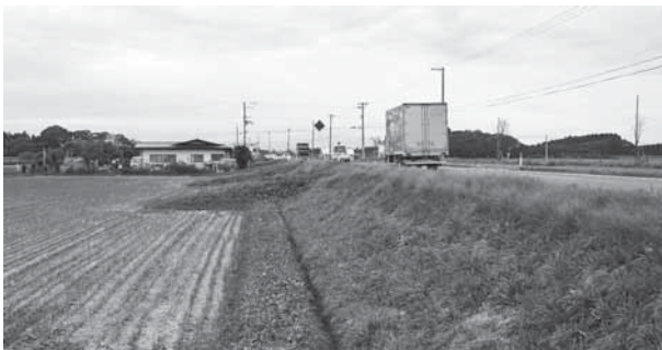
盛土された県道
