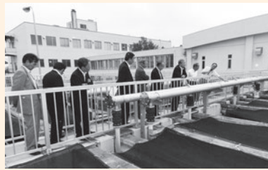
▲白山浄水場の水をろ過する過程の中の一つ。安心して飲める水道水を作るために、多くの施設や人の手で成り立っている。
