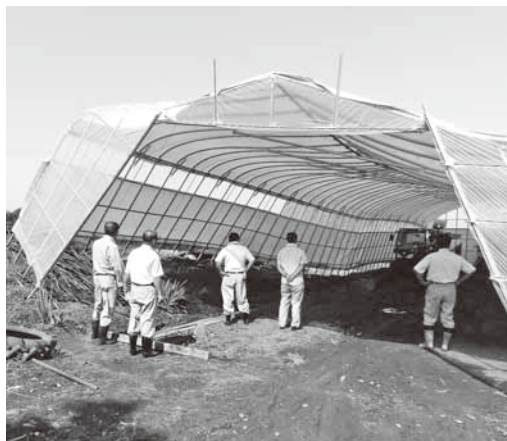
損壊したパイプハウスを調査
