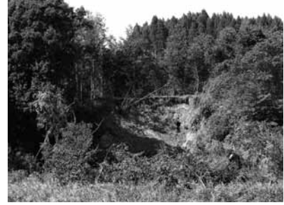
大雨によって崩れた斜面
