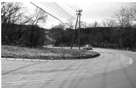
道路の幅が狭く、見通しも悪い。 特に冬期間は注意が必要である。
