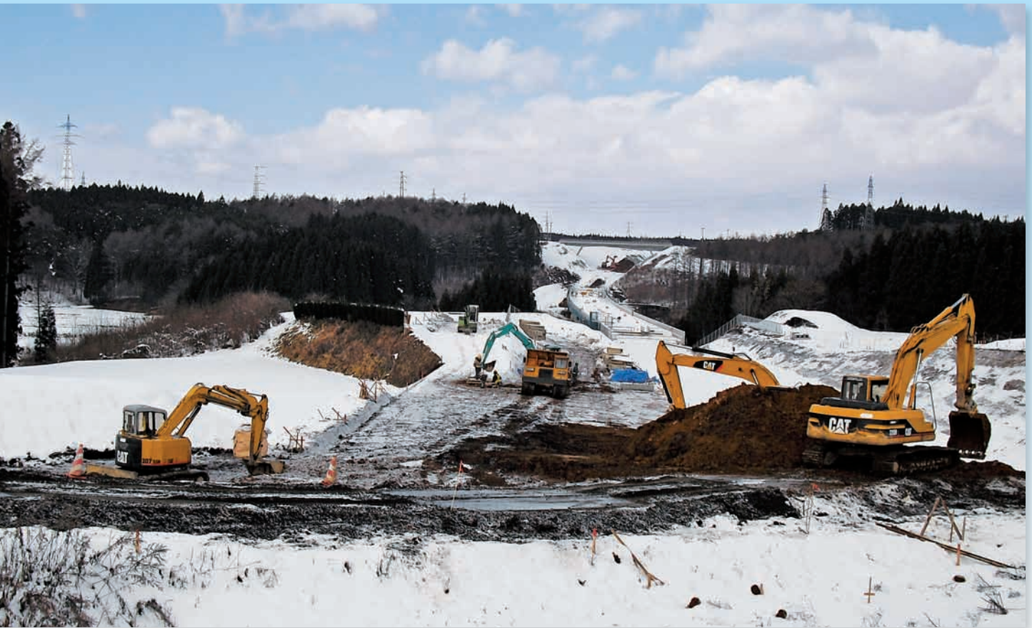
「工事が進む上北道路」
